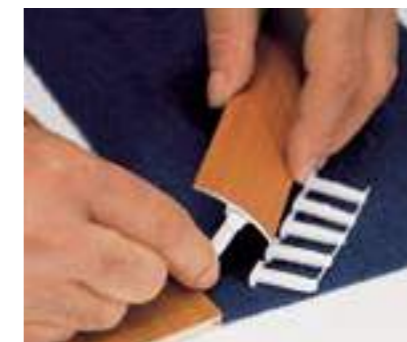
introduzir os tacos no canal na zona inferior do perfil, ajustando as posições de modo a que coincidam com os furos no pavimento
