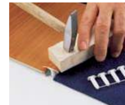
aplicar o perfil sob pressão, com um maço de madeira ou borracha
