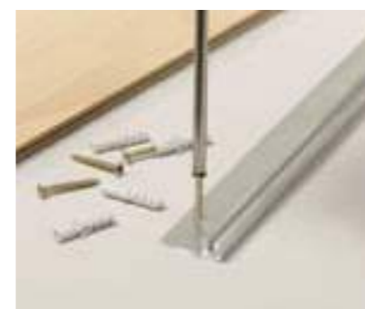
furar o pavimento e fixar a base
