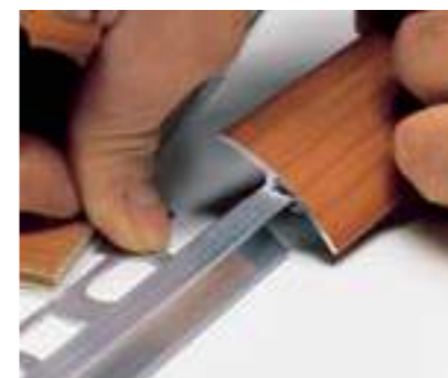
encaixar a base profix no canal na zona inferior do perfil
