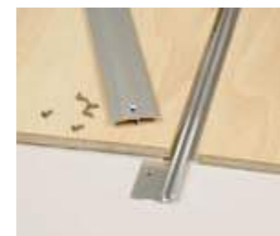
aproximar o pavimento
