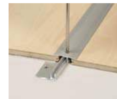
fixar o perfil superior na base com os parafusos fornecidos
