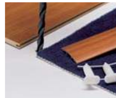
furar o pavimento com uma broca de Ø mm 6
